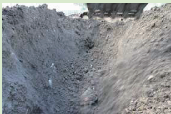
攪拌最終段階 粘性土が砂粒化 大型0.7 m³バックホー(スケルトン)
