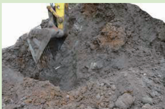
攪拌初期 粉体VOC分解剤使用例
